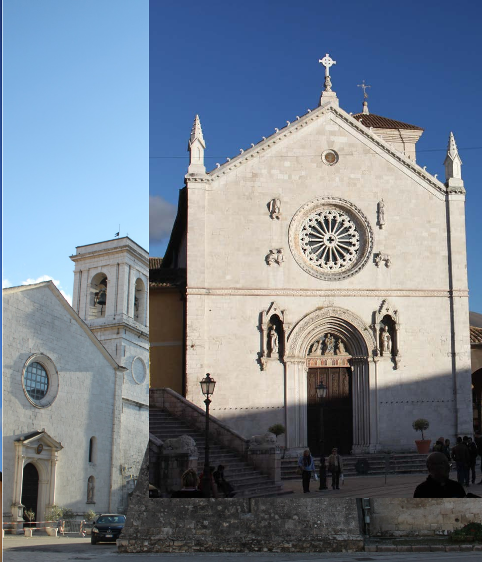
Norcia (16/10/2016) Dommages limités et exemples de dispositions constructives et d'urbanisme Règlements pour la reconstruction en 1859 (puis 1979 et 1997)
