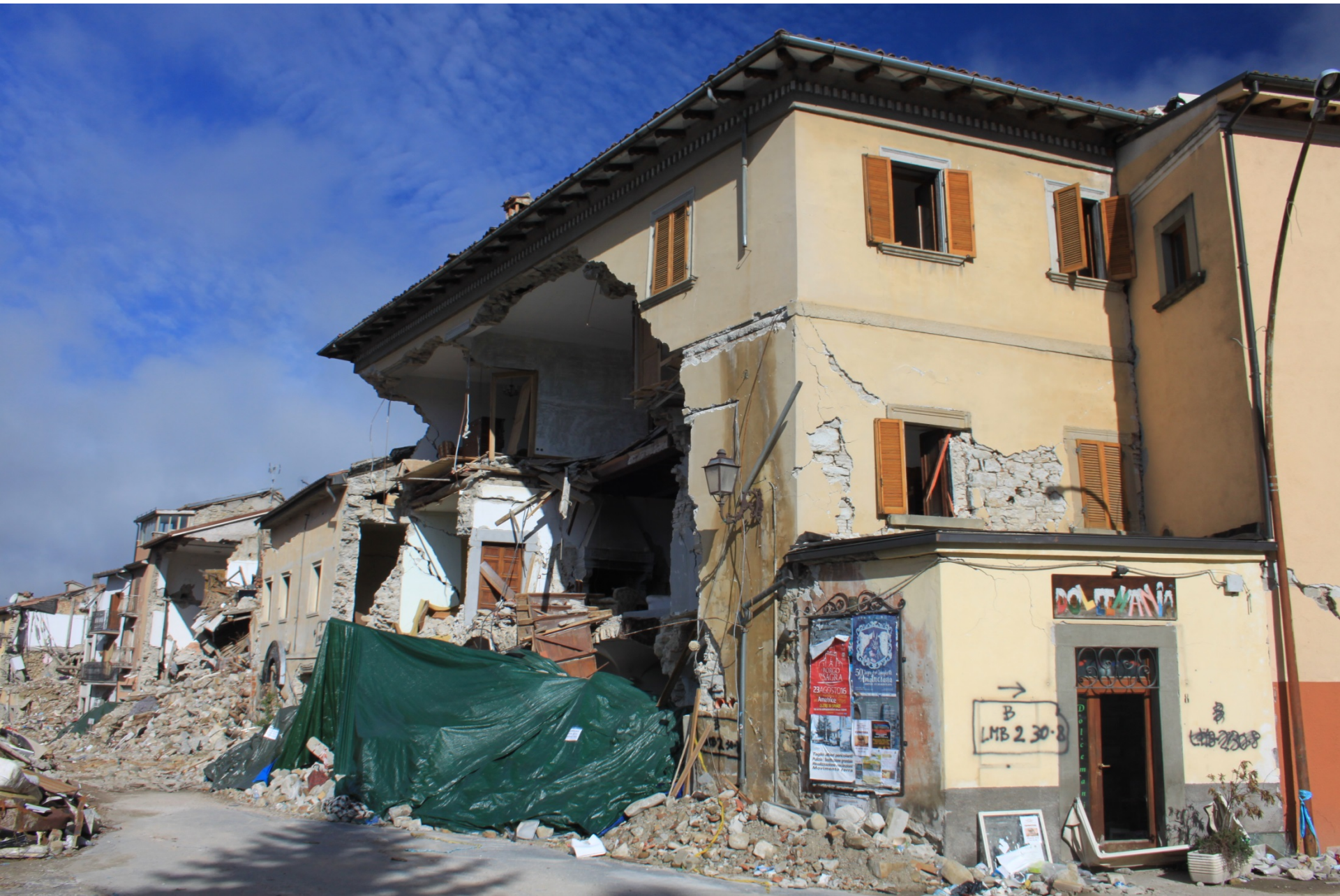
Bloc de bâtiments en maçonnerie à l'entrée de la zone rouge d'Amatrice
