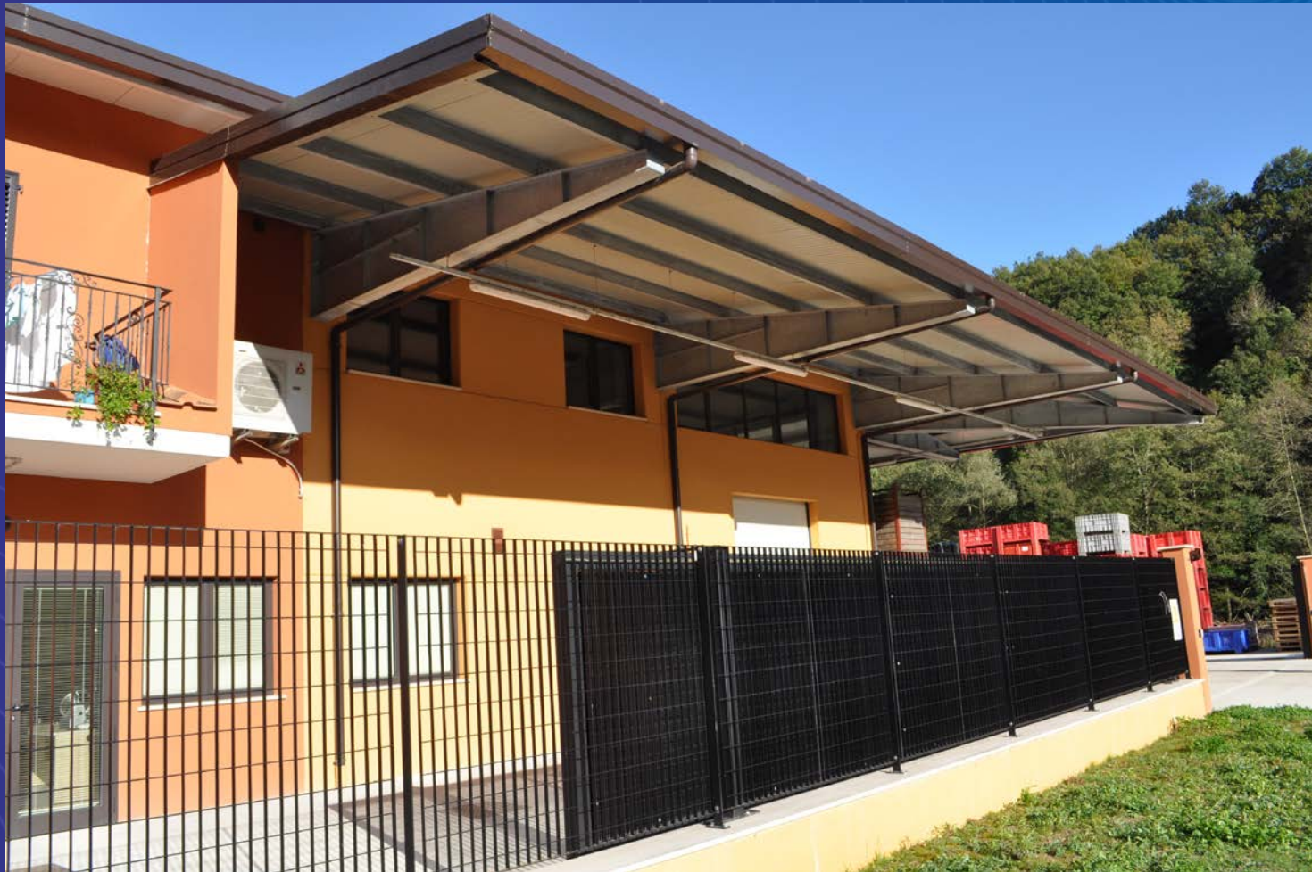
Usine récente à Arquata del Tronto – absence de dommage
