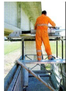
Installation d'amortisseurs
