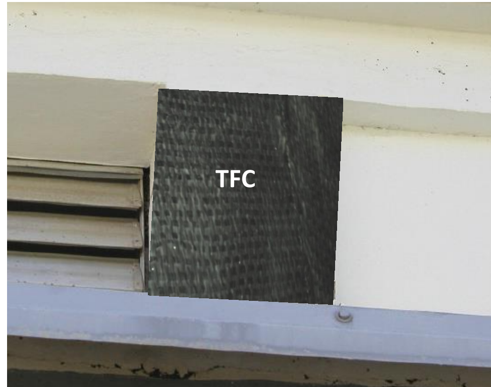
Réparation par chemisage avec TFC
