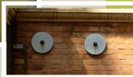
Ajout de chaînages horizontaux et verticaux encadrant les maçonneries
