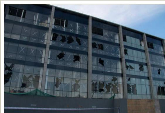
FAÇADE VITRÉE ENDOMMAGÉE PAR UN SÉISME (©EDUARDO MIRANDA)
