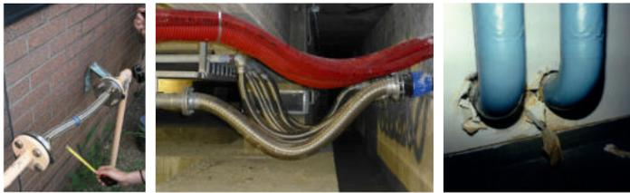
DÉGATS AUTOUR D'UNE CANALISATION ET RENFORCEMENT PAR AJOUT DE FLEXIBLES (©DDT65 ; AFPS ; MASON INDUSTRIE)
